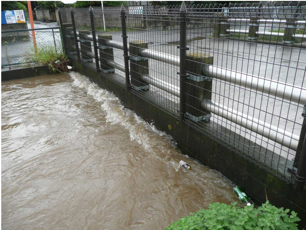
菰川出水状況（伊勢崎市）
